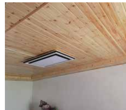
改造后的屋顶
