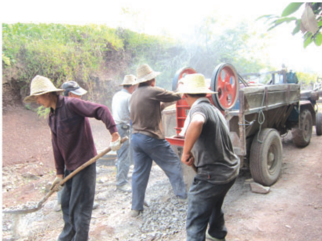
村民参与道路整治项目的施工
