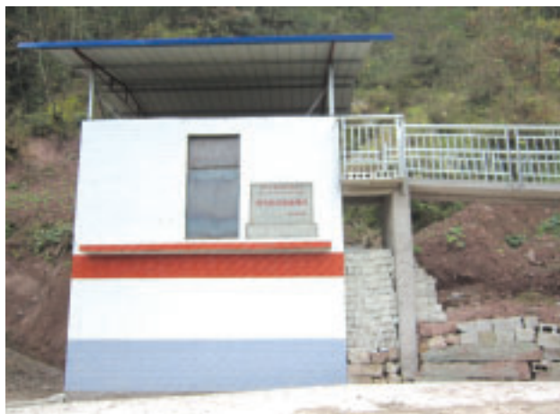
河马村垃圾池项目
